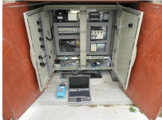
Mesure de débit sur poste de refoulement avec pinces ampérométrique ou débitmètre sur refoulement
